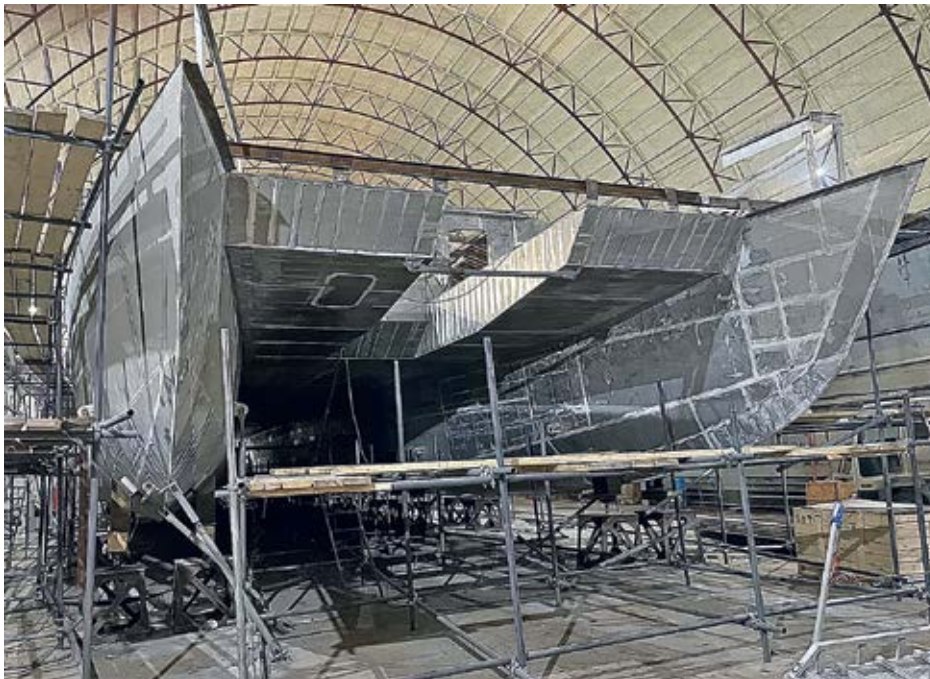
Достройка на производственной базе ВСРП в Иркутске
