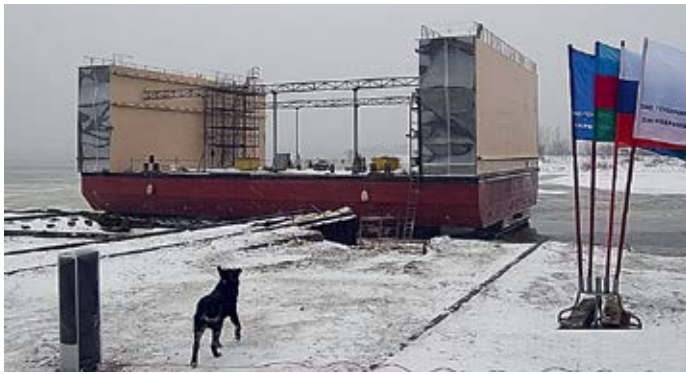
Спуск блока дока пр.28140, 2012 г.
